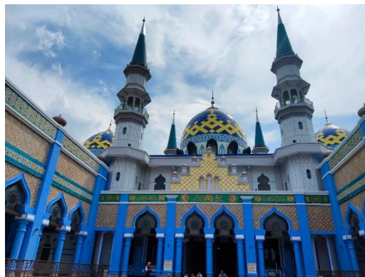
Gambar 2.1 Atap Masjid Agung Tuban (Sumber: Dokumentasi 2022)
